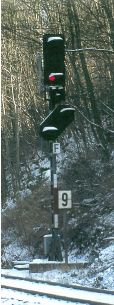
Voorbeeld van een inrijsein 76397. Bij het beeld "stop" is het voorsein gevoerd.
